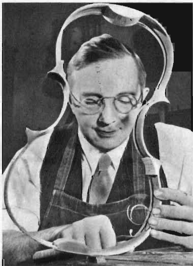
Kar A. Berger lavora con cura i fianchi di una cassa di viola prima di mettere insieme lo strumento. Egli ha studiato presso Meinl di Basilea e Postiglioni di Napoli.
