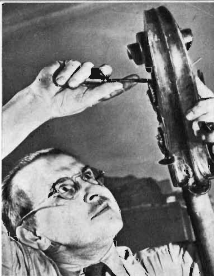
Ecco un liutaio che lavora alle chiavi di un contrabbasso. Egli ora sta fissando mediante viti le chiavi, che sono a ruota e vite senza fine, dato lo sforzo che debbono sopportare.
